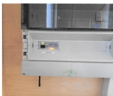
Billede af tændt sauna: Grøn og gul lampe lyser
